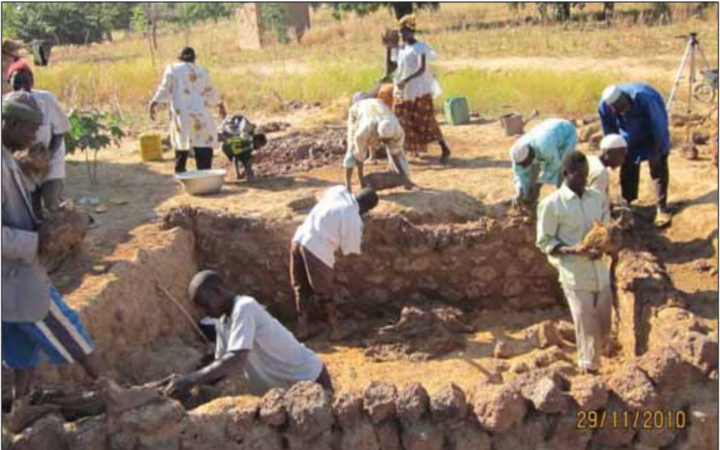
Photo 4 : Construction des parois d'une fosse fumière avec des matériaux locaux en remplacement du ciment par l'Association Tind Yalgré (ATY) de Boussé
