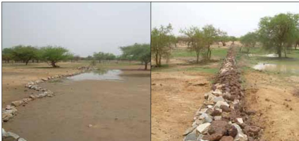
*Photo 9 : Les cordons pierreux et les digues filtrantes protègent les sols et permettent à l'eau de s'infiltrer dans le sol*
