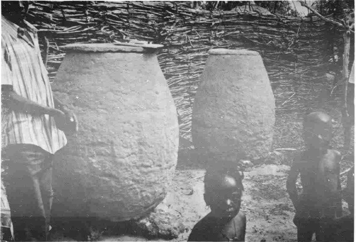
Grenier en banco qu'on rencontre un peu partout, il sert à stocker les céréales dans le concession. L'accès qui se trouve au sommet est recouvert d'un couvercle en banco qui très souvent est protégé par une coiffe en paille. Il mesure à peu près 1,5 mètres de hauteur et moins d'un mètre de diamètre. Les céréales sont stockées généralement en grains.
