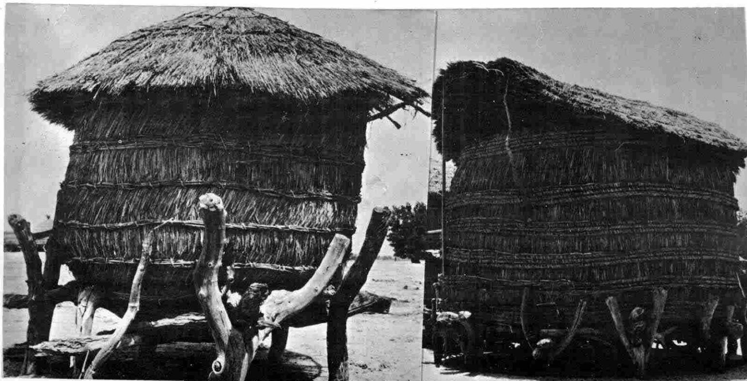
"ROUMBOU", greniers en paille typique de l'Est, construits avec des tiges d'Andropogon gayanus et des tiges d'arbustes en forme de tronc de cône. L'accès est situé au sommet en soulevant la coiffe (voir photo) ; c'est une variante du type 7. Ils mesurent généralement 2 à 3 mètres de diamètre à la base, 1 à 2 mètres de diamètre au sommet ; la hauteur fait 2 mètres. Les céréales sont stockées en épis ou en glumes pour le mil.
